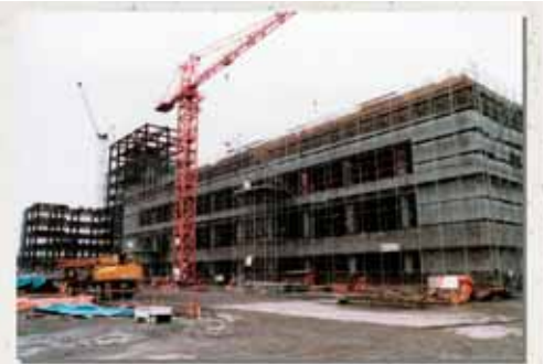
外束棟の工事風景(昭和57年9月頃)
