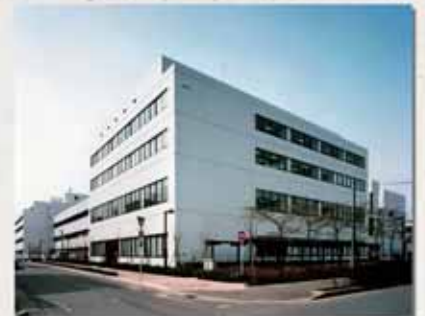
研究棟新築(平成3年7月)
