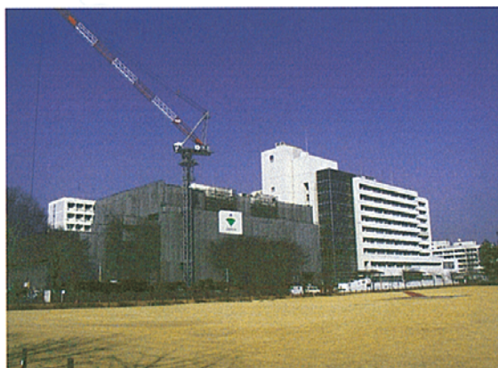
2004(平成16)年2月中旬：工事状況写真
