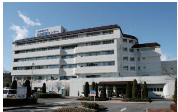
(改修工事が完了した日光医療センター)
